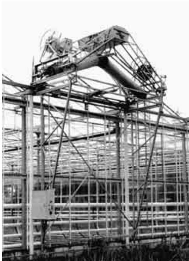
Fig. 3.7 Het verplaatsen van de dekwasser naar de volgende kap
