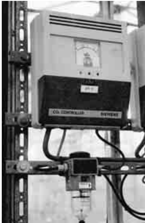
Fig. 3.15 Op een CO 2 -meter kun je het CO 2 -gehalte eenvoudig aflezen.
